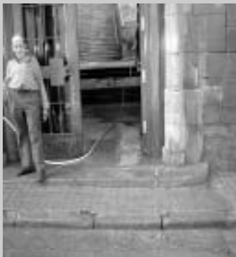
L'hospital sense rampa per a minusvàlids
