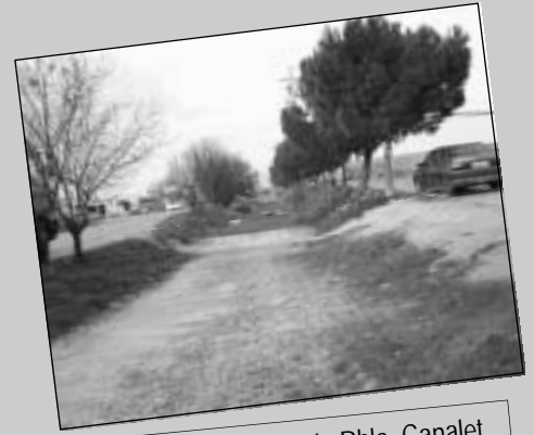
Lamentable estat de la Rbla. Canalet
